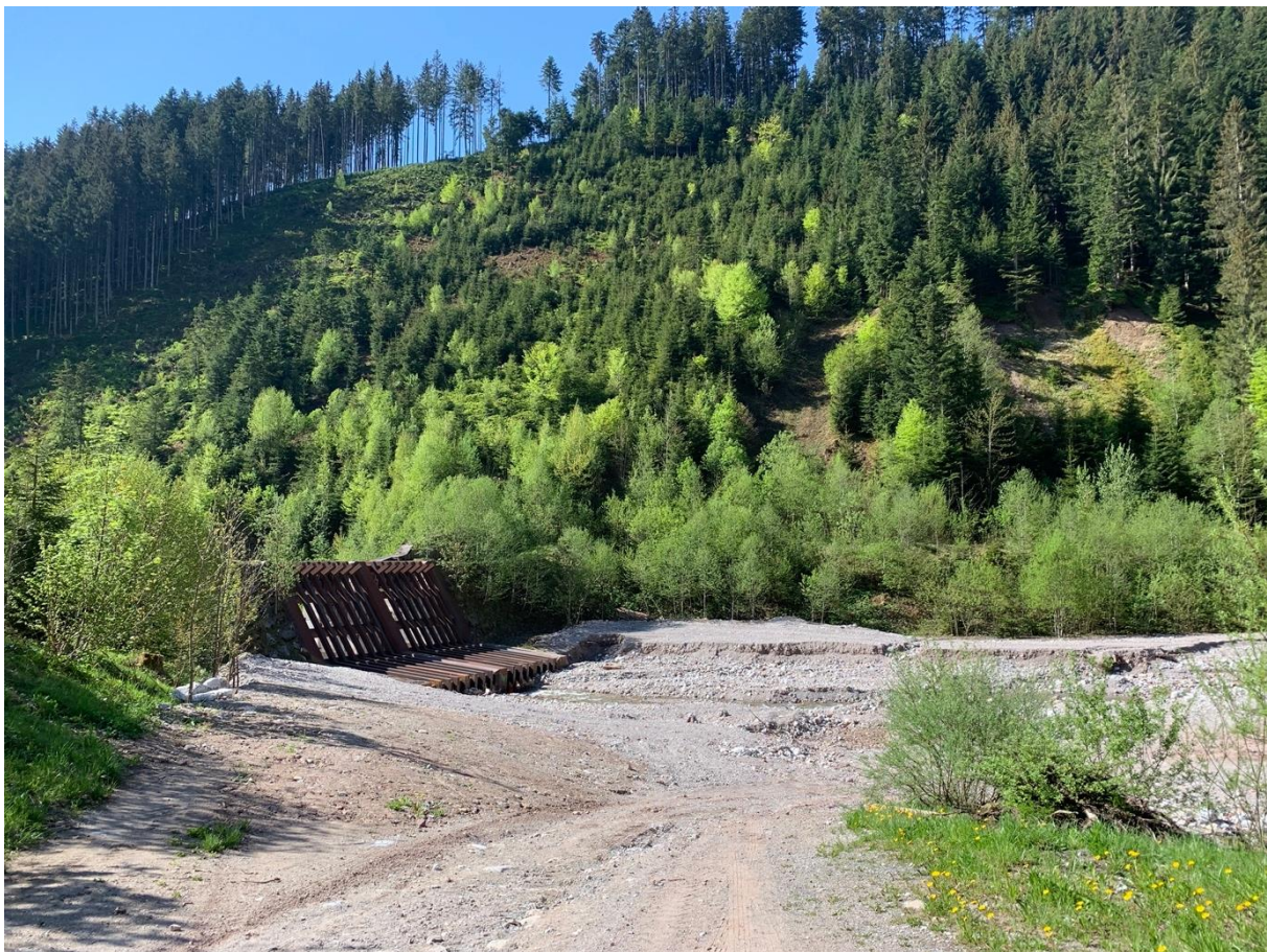
WLV Schutzprojekt Birnbach: Filterbauwerk mit Ausschotterungsbecken & Wasserbausteine zur Gerinnestabilisierung
